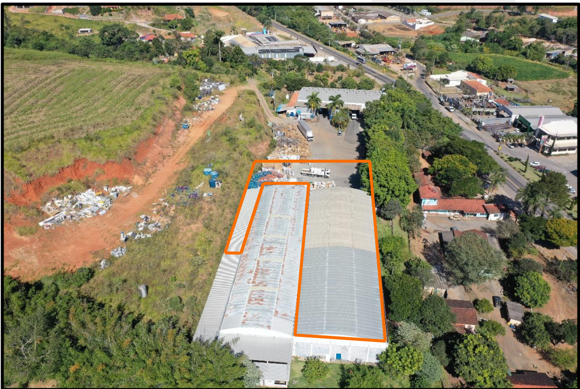
Figura 20 – Imagem aérea de outro ângulo do empreendimento, indicado pela seta laranja. Fonte: COAMI, 2023.
