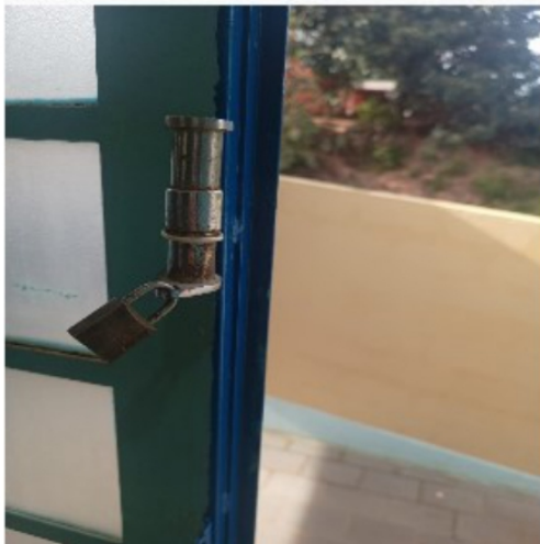
Maçaneta de fechamento da janela quebrada
