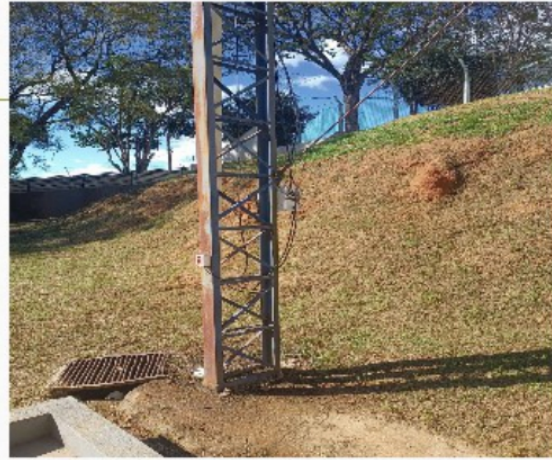
Calhas entupidas, grade do chão e fios soltos
