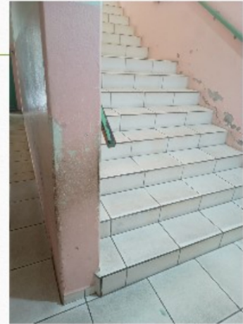
Ínicio da escada em desnível e sem anti derrapante, pintura das paredes
