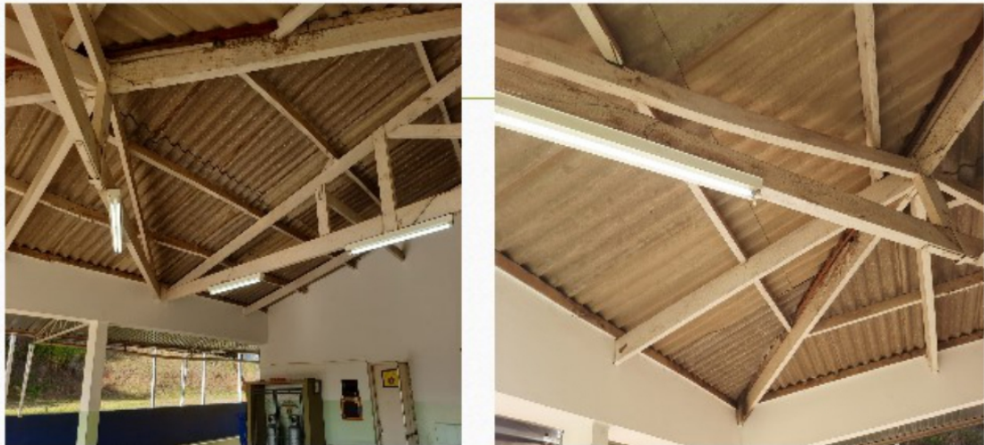
Lâmpadas queimadas e amarradas no madeiramento, pintura
