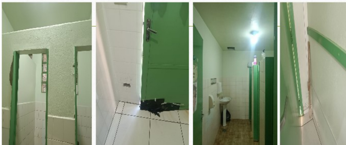
Sem tampa da válvula da descarga, portas quebradas, parede
