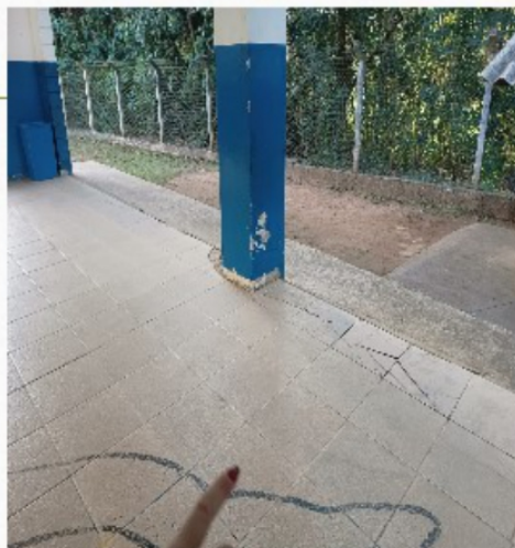
Pátio – pintura e pisos trincados
