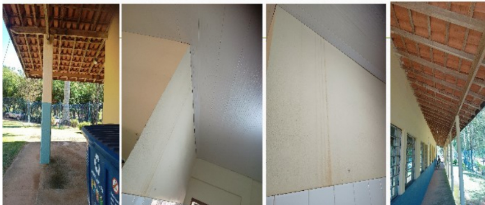
Mofo consequência de vazamento no telhado
