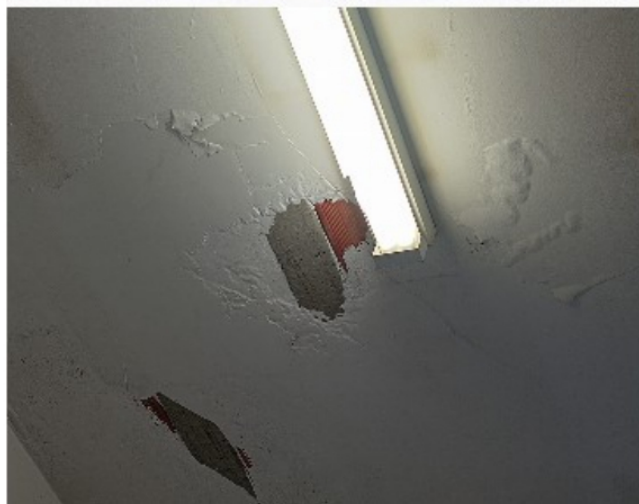
Trincas nas paredes.
