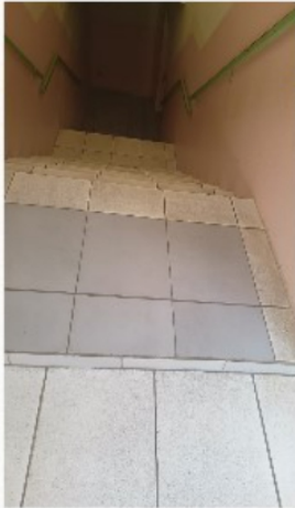
Ínicio da escada em desnível e sem anti derrapante, pintura das paredes
