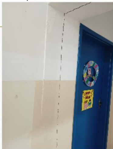
Trincas nas paredes.
