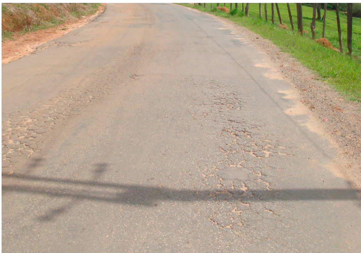
Estrada vicinal do bairro do oratório
