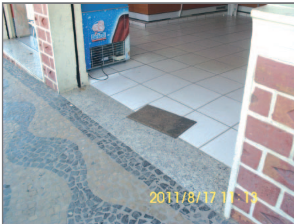
Tirando o tapete, este é um exemplo correto de entrada nos moldes de acessibilidade da NBR 9050
