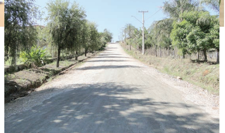
Trechos das Ruas Rafael Dias de Oliveira (foto acima), Antonio Sartori e Vicente Corsi, no Saltinho, serão asfaltadas. Além de praça que será construída próximo à Igreja de Santa Rita, com academia ao ar livre e playground.
