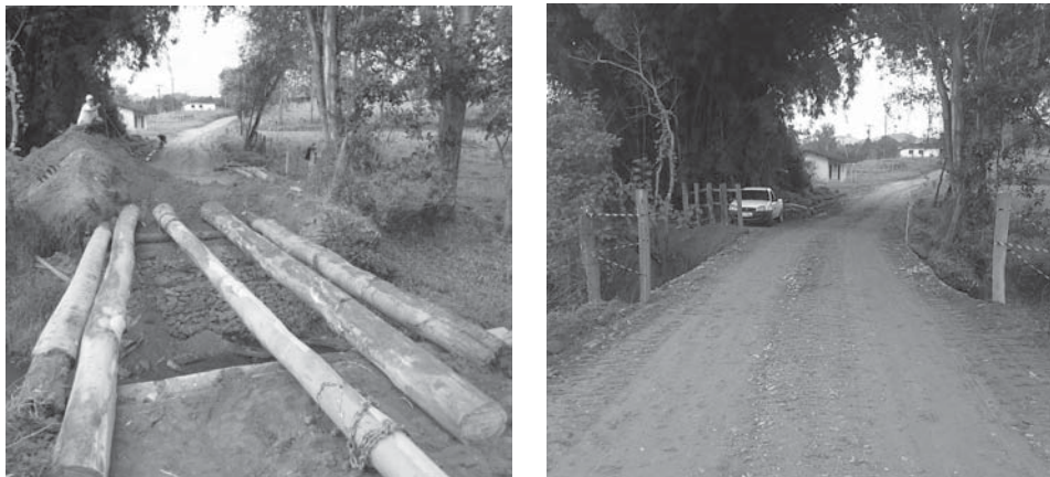
Fotos do antes e depois da realização da obra pelo Departamento de Obras, Serviços e Estradas Rurais da Prefeitura
