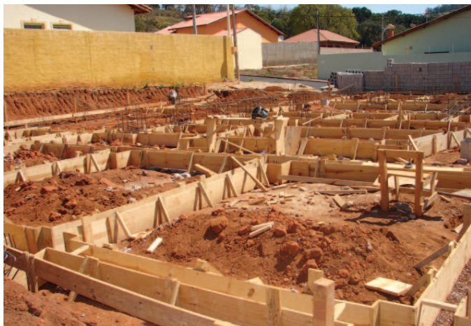
Obra da nova Unidade Básica de Saúde do Parque Ferrúcio
