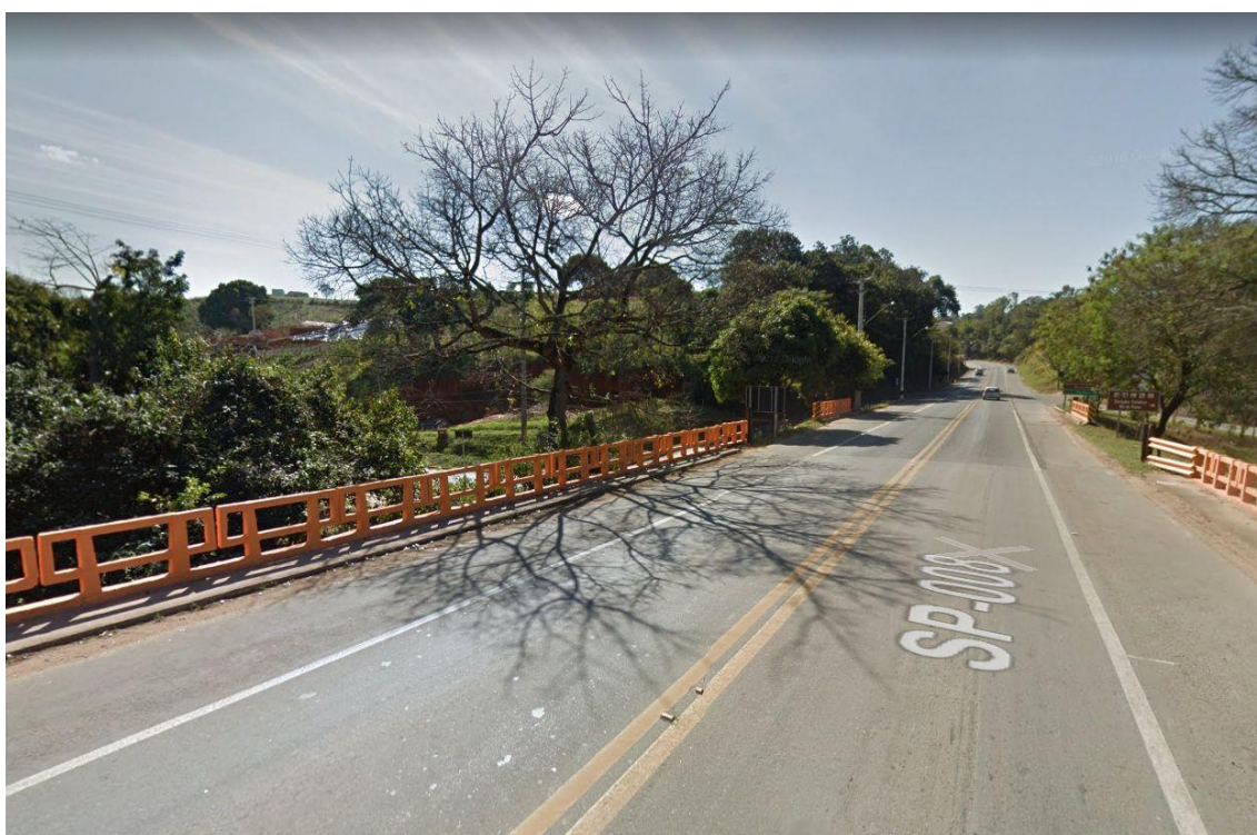
Foto 17: Ponte sobre o Rio do Peixe, na área de influência direta (AID).
