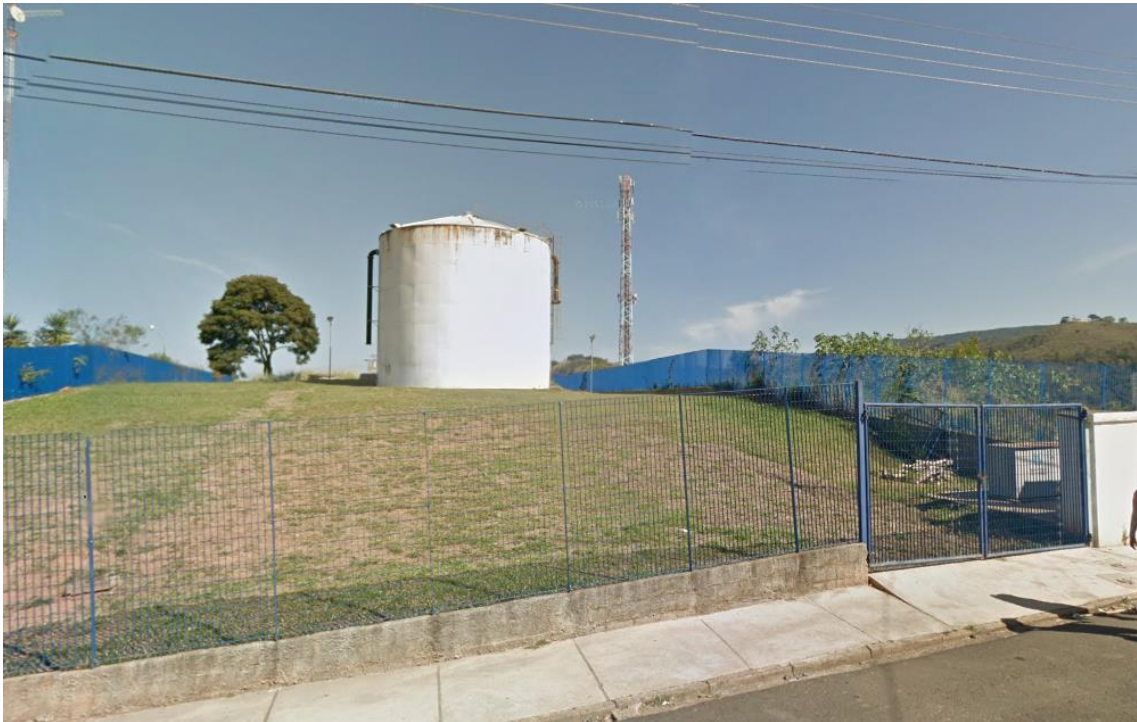
Foto 8: Caixa d'água da Sabesp.
